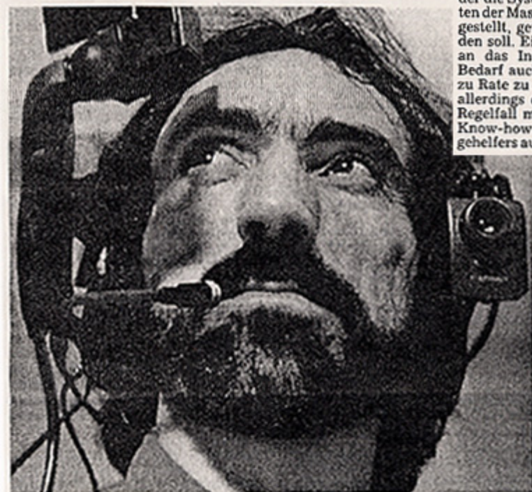
Die Menschmaschine : Der Informatiker Wolfgang Wohlgemuth demonstriert die Ausrüstung, mit der Facharbeiter der Zukunft Verbindung zu einem Computer halten, dem sie die Situation vor Ort mit einer Kopfkamera zeigen können und der ihnen dementsprechend genaue Anweisungen auch optisch vermitteln kann. Foto: Frank Boxer
